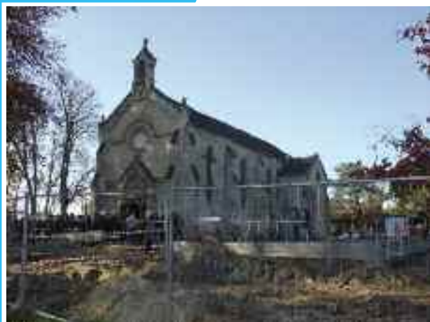
Chapelle de Mussonville : chantier réhabilitation
