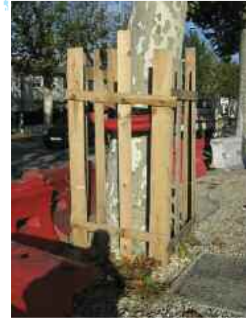
Chantier esplanade Saint-François
