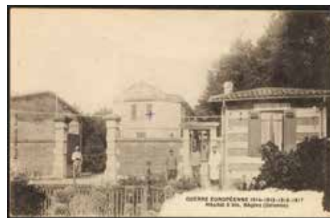
« Guerre Européenne 1914-1915-1916-1917 ». Portail d'entrée de l'Hôpital 5 bis. 4Fi 118, AM Bègles ▲
